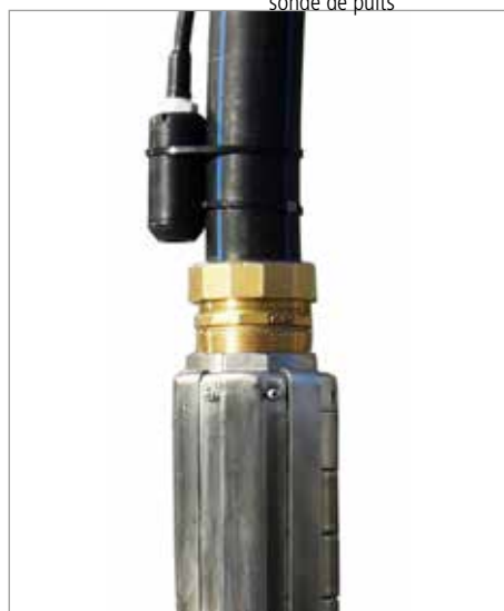
Figure 22 : fixation de la sonde de puits
