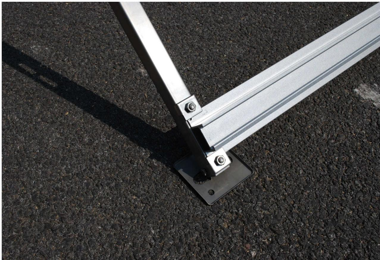
Etape 13 : Fixer la partie basse du capteur avec les pièces de fixation
