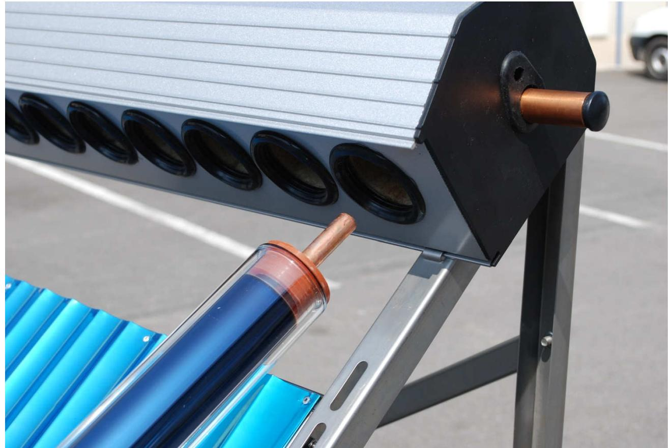
Etape 18 : Fixer la douille de transfert thermique dans le collecteur
